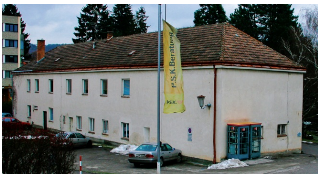
Abb. 23: altes Gemeindezentrum 2006 (West-Ansicht)
