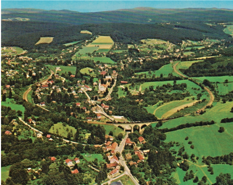
Abb. 21: Blick auf Westbahnbogen, 1980 FVV: Eichgraben in alten Ansichten, S. 57.
